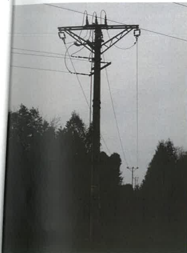
Odłącznik nr RE-1 Ł1933 linii 15 kV Olszyny Kopalnia Gazu
