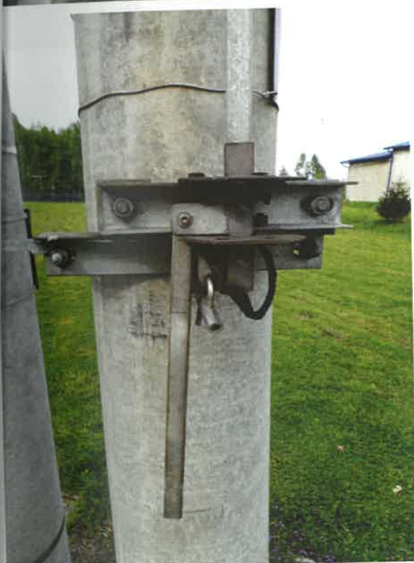
„Odłącznik wyłączony „- układ cięga
