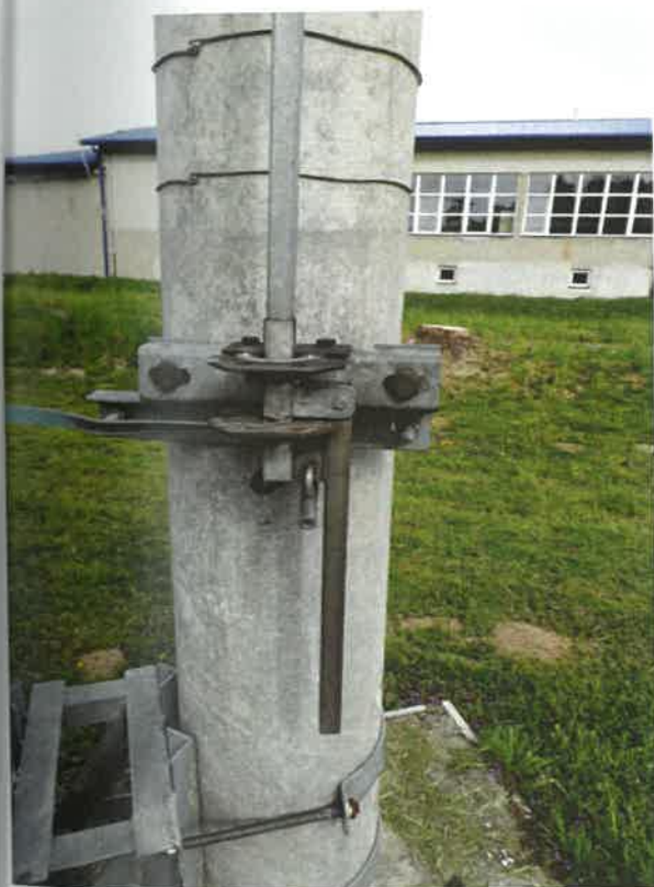
„Odłącznik załączony „- układ cięgna
